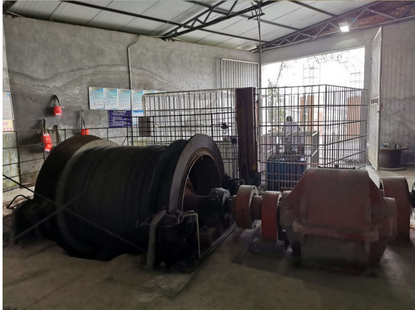
(附项目勘察相关图片)
